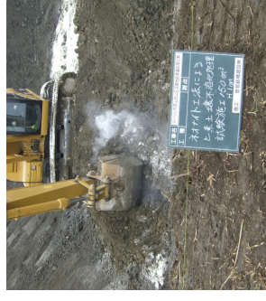
バックフォアによる不溶化作業
