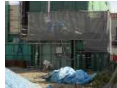
フッ素汚染土地下水処理現場
