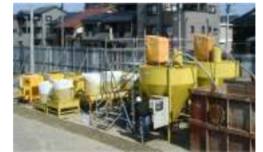
地下掘削(砒素処理)の基礎工事現場
