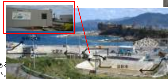
原子力発電所大規模埋め立て造成現場
