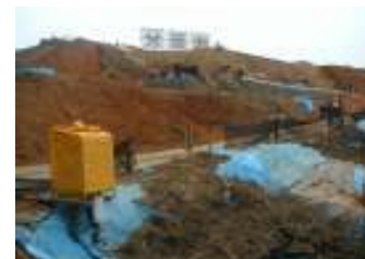
大型宅地造成現場全景
