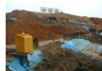
大型宅地造成現場全景
