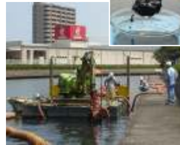
台船等で泥水を搬送
