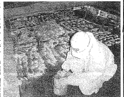
塗料ゴミが落ちた床面に処理剤を散布すると安全に処分できるようになる
